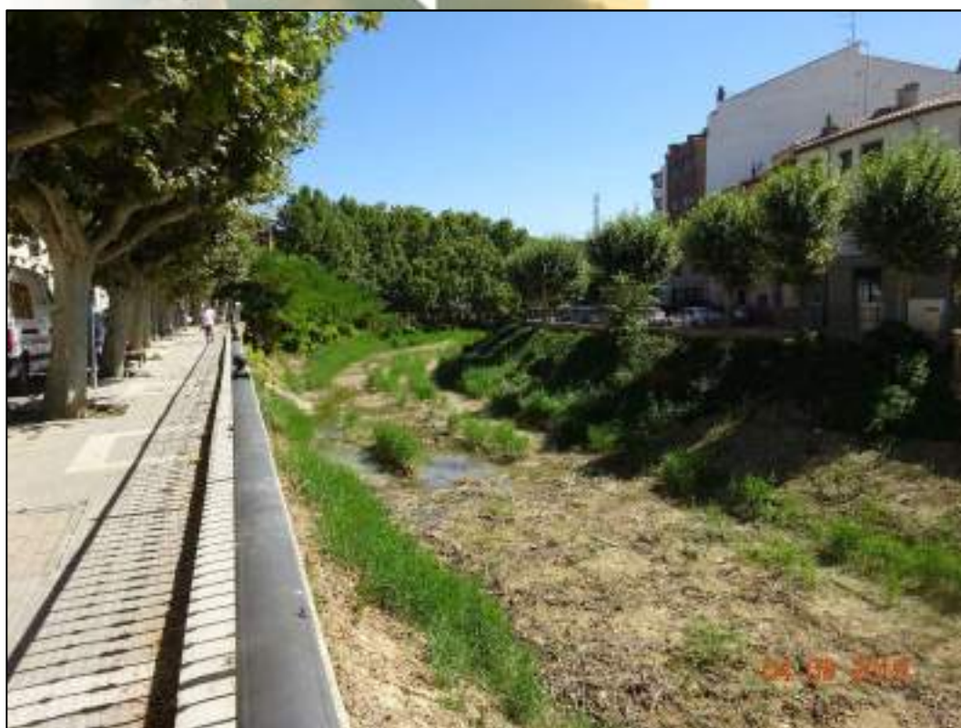
Ilustración 63. Vistas del cauce del Cidacos, desde el puente de la NA-132, hacia aguas arriba, casi dos meses después del evento de julio de 2019.
