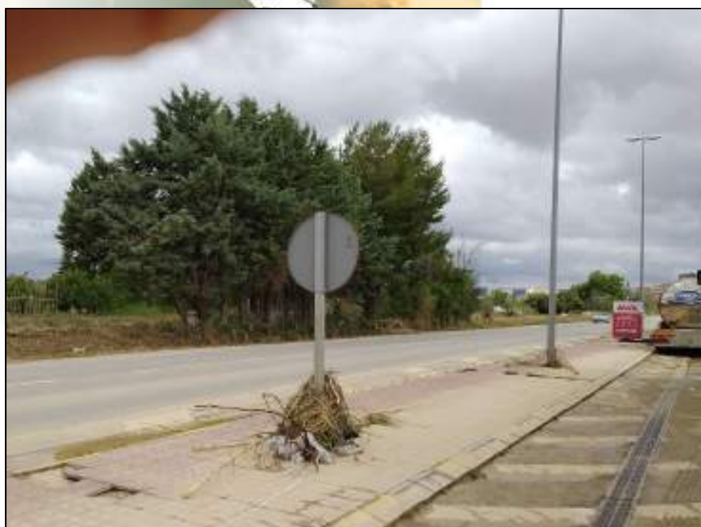
Ilustración 41. Efectos de la riada, fotografiados el día 9 de julio de 2019. Imágenes tomadas en la zona sur de la localidad. La fotografía superior muestra cómo un coche fue arrastrado contra el muro que protege el campo de fútbol, en una de las rotondas con riesgo de inundación en el municipio. La fotografía inferior, tomada algo más al sur, demuestra como el calado de la inundación que circulo por la zona de la gasolinera, fue también de gran importancia y peligrosidad.
