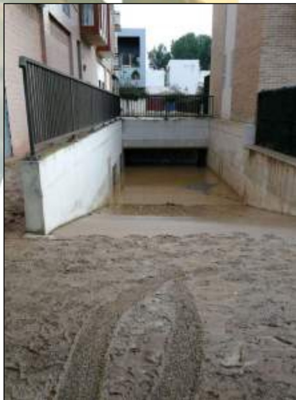
Ilustración 35. Garajes inundados con calados muy importantes y de gran peligrosidad en la calle Amatriain.
