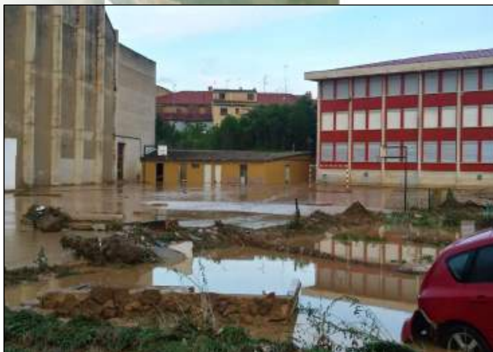
Ilustración 37. Instalaciones del centro educativo Escolapios. Centro que también resultó afectado por las inundaciones.
