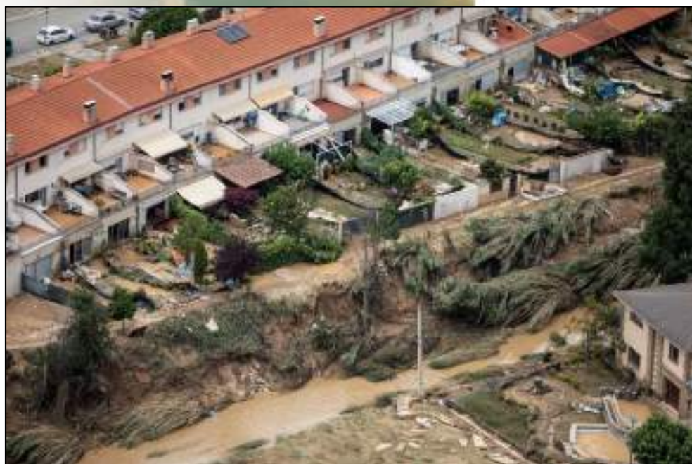
Ilustración 33. Resultado de la fuerza de la riada sobre las casas de la calle Macocha, situada en la margen derecha del Cidacos.
