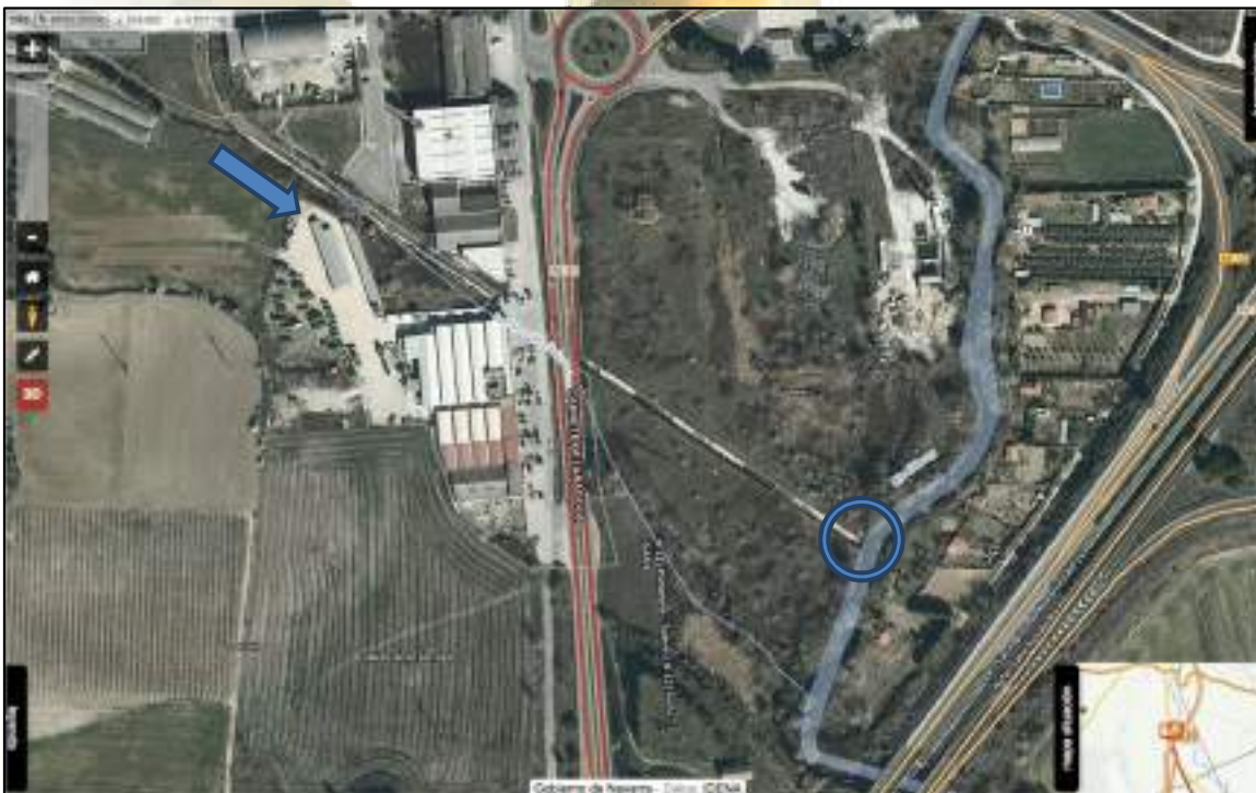
Ilustración 6. Imágenes de detalle de los puntos de entrada y salida del barranco en el casco urbano de Tafalla. En la imagen superior se muestra el punto en el que el barranco del Ábaco se soterra al llegar al polígono industrial. En la imagen inferior se muestra el punto en el que el barranco del Ábaco, ya junto con el cauce del barranco de Badinas, desemboca en el cauce del Cidacos. Imágenes obtenidas de IDENA ( https://idena.navarra.es/navegar/ ) y Google.
