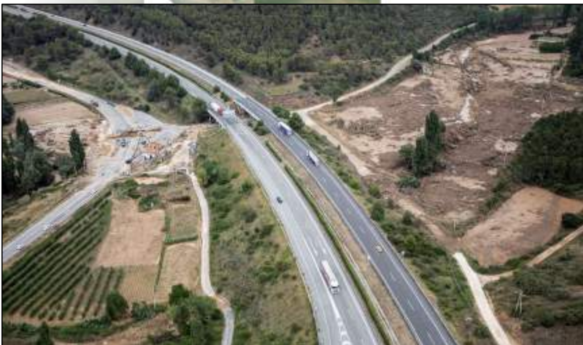
Ilustración 26. Imagen aérea de la zona de salida del barranco del río Sansoain, que tras cruzar canalizado bajo la autopista Ap-15, aporta sus aguas al río Cidacos aguas arriba de Tafalla.
