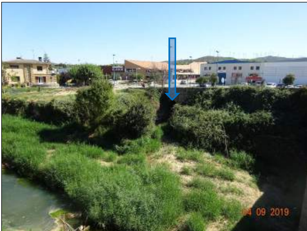
Ilustración 57. Fotografías tomadas - hacia aguas arriba - desde el puente de la calle Panueva. En la imagen superior aparecen las casas del camino Macocha/Makotxa, unas de las viviendas más afectadas en la margen derecha por el desbordamiento del río de julio de 2019. En la fotografía inferior aparece señalado el punto en el que desembocan en el Cidacos los barrancos visitados en el punto anterior.
