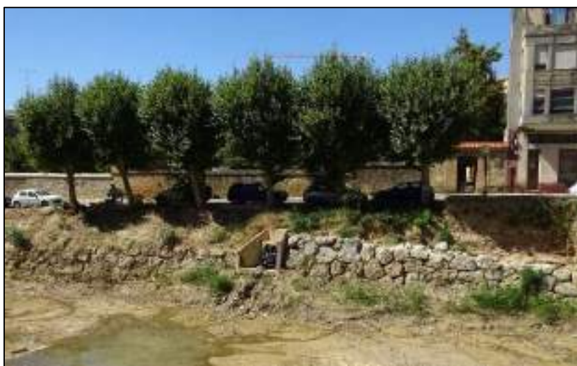
Ilustración 47. Imagen de la clapeta anti-retorno por la que se vierten las aguas pluviales de la margen derecha del casco urbano, justo aguas abajo del puente de la estación.
